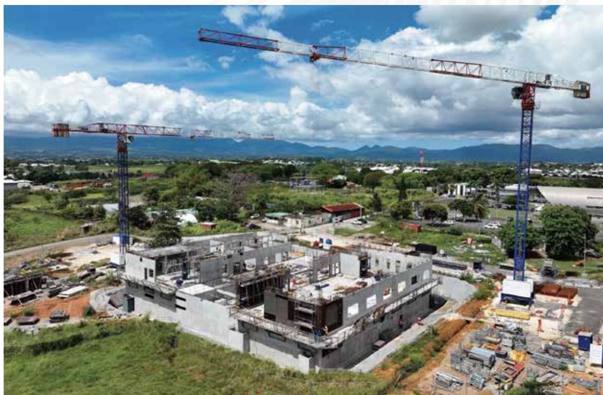
Construction du nouveau siège d'EDF - Technopôle Audacia Baie-Mahault
