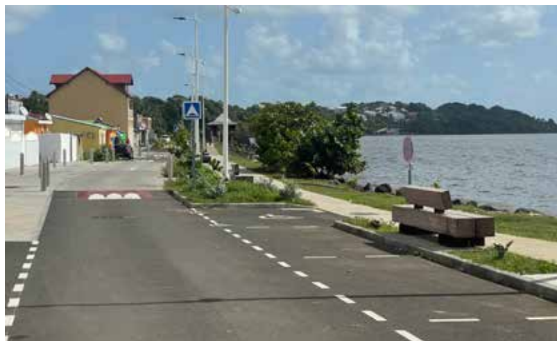
Travaux d'aménagement du Boulevard Omer Ninine
