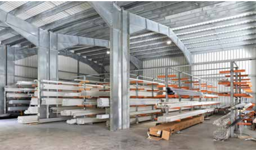
Une partie du stockage du nouveau dépôt
